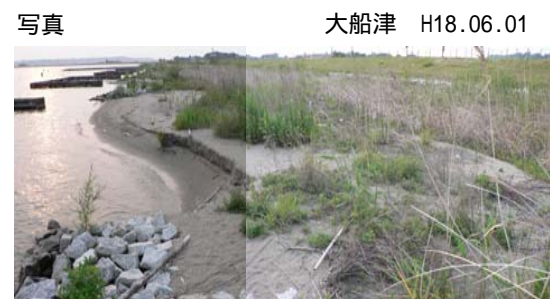
人工バームの無い箇所は養浜水際の砂が侵食されている
