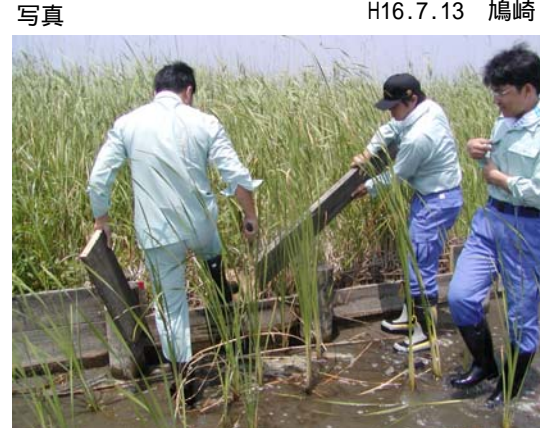
植生の繁茂により裸地的環境が消失したため板柵撤去作業を実施
