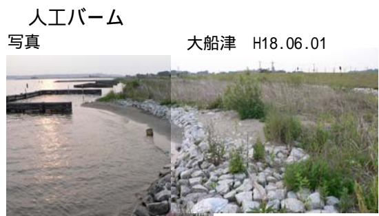
人工バームにより水際の砂が押さえられている
