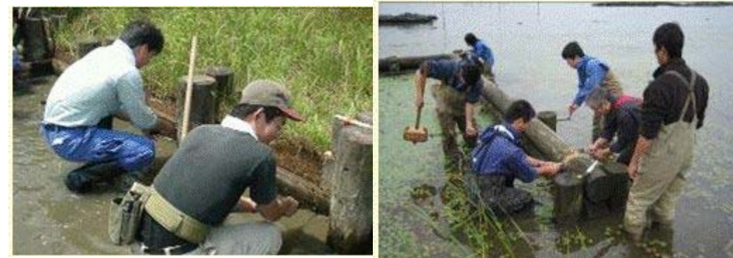
消波構造物の試験的な撤去
