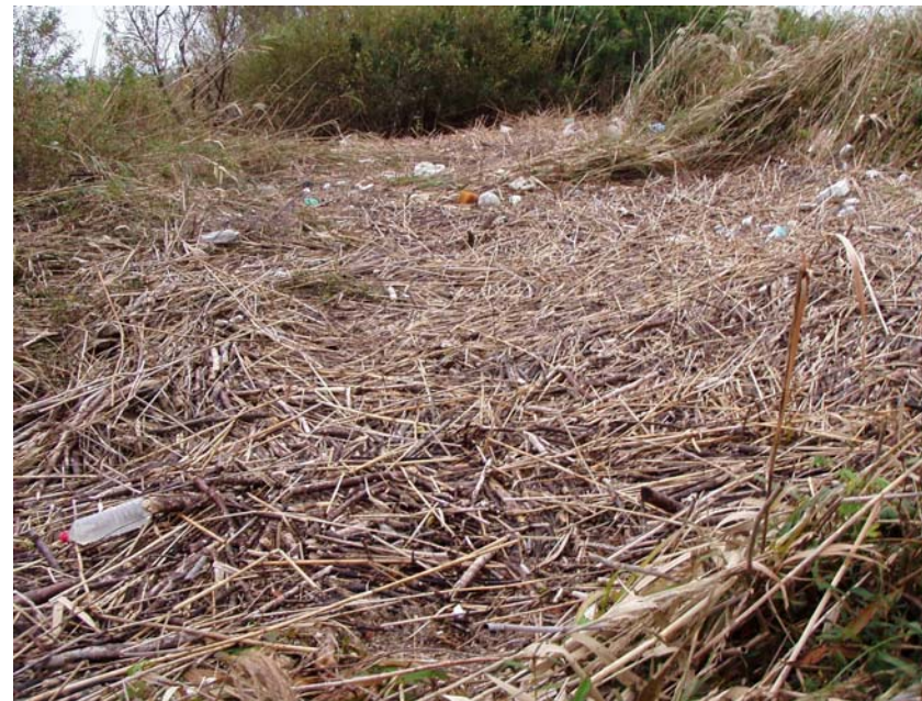
平成16年10月 鳩崎地区 台風22号高水位後 内蔵粗朶大量に流出
