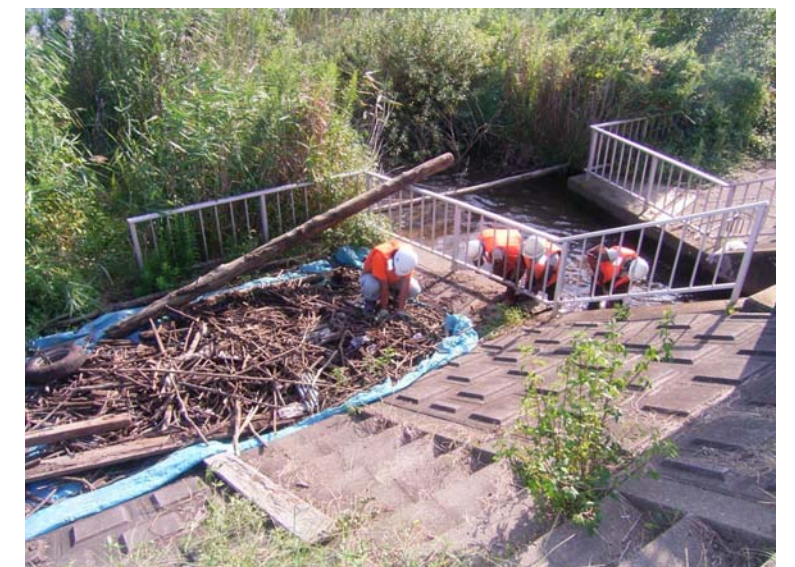
平成18年9月 樋管からの粗朶撤去作業状況
