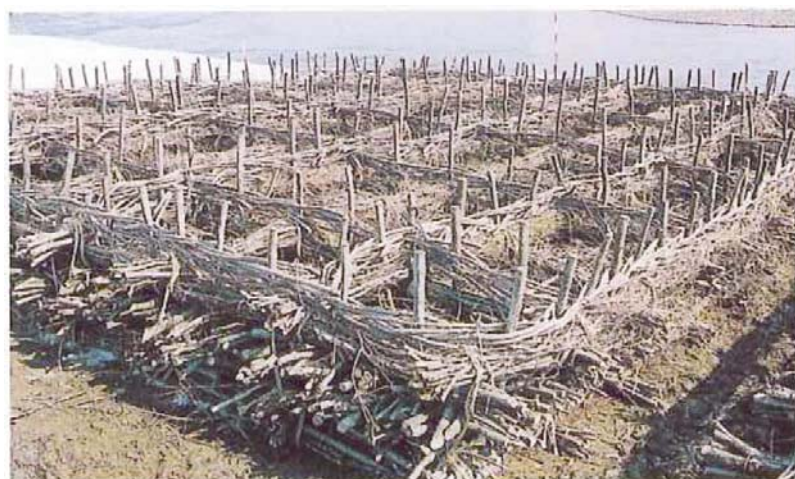
杭木打ち込み
